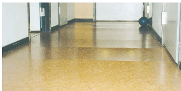
Fukt har trängt igenom den underliggande folien och har medfört att spånskivan svällt, nedbrytning av lim och blåsbildning på mattan.
