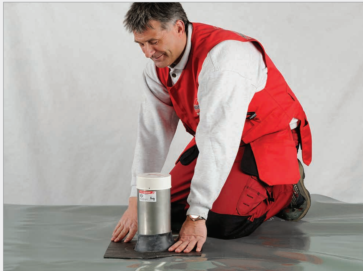
Principskiss, placering av radonsug
